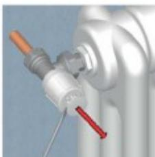
Открутить белую ручку против часовой стрелки, и снять ее с вентиля.
